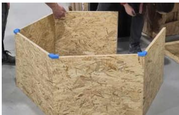
Figure 2: Principe d'assemblage des panneaux
